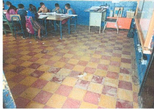
Foto 1: SUSTITUCION DE PISO POR DETERIORO SALON 2
