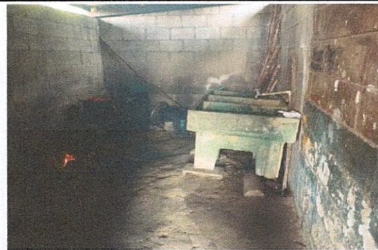
Foto 4: SUSTITUCION DE POLLETON POR DETERIORO
